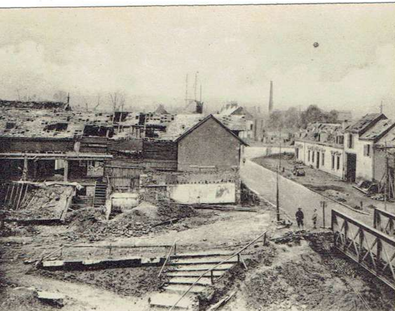
Visé Paris n° 913 919 HAM. — Route de Noyon et Pont sur le Canal. Road of Noyon and bridge on
