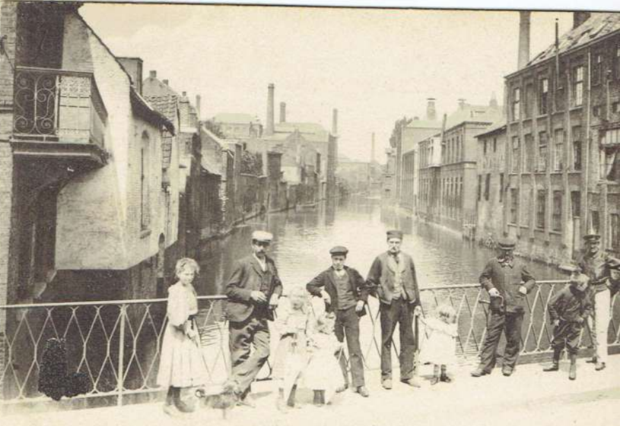
80 ARMENTIÈRES. — Le Pont de Flandre. — LL.
